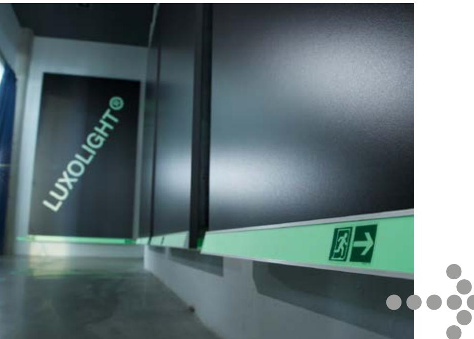
Die Installation eines langnachleuchtenden bodennahen Sicherheitsleitsystems ist eine wichtige Schutzmaßnahme für den Evakuierungsfall. Als Bestandteil des Sicherheitskonzeptes oder als Ergebnis aus der Gefährdungsbeurteilung müssen Arbeitsplätze und Aufenthaltsorte mit erhöhtem Gefährdungspotenzial für den Notfall mit einem optischen Sicherheitsleitsystem ausgestattet werden, das den anwesenden Menschen den Weg in eine sichere Umgebung oder zu Sammelplätzen anzeigt.
